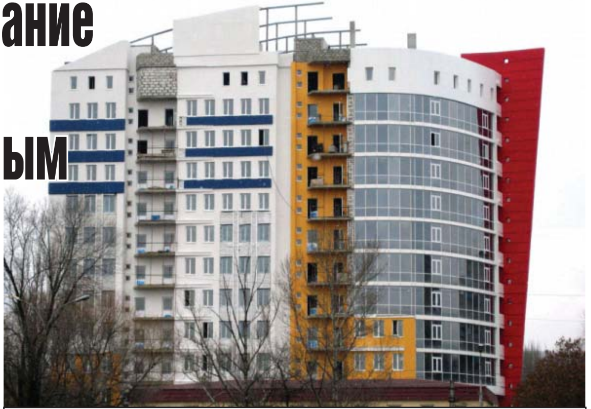
Специалисты уверяют, что для объектов массового строительства достаточно проведения экспертизы.
